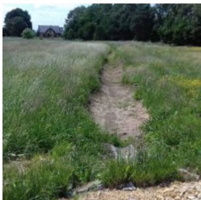
Rozpoczęcie robót dróg
