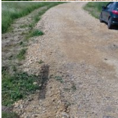
Rozpoczęcie robót dróg
