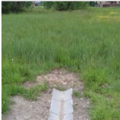
Rozpoczęcie robót dróg
