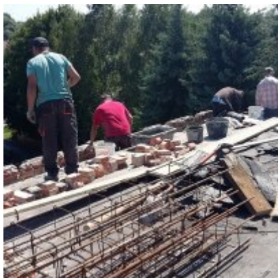
MODERNIZACJA DACHU NA BUDYNKU ZSO w PODOLSZU
