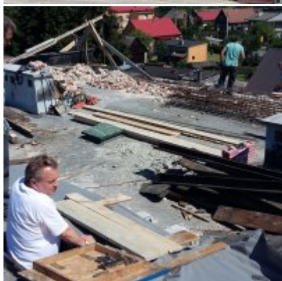
MODERNIZACJA DACHU NA BUDYNKU ZSO w PODOLSZU
