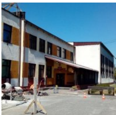
MODERNIZACJA DACHU NA BUDYNKU ZSO w PODOLSZU
