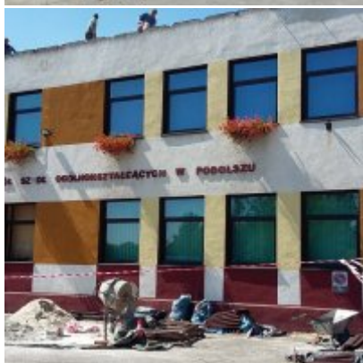
MODERNIZACJA DACHU NA BUDYNKU ZSO w PODOLSZU
